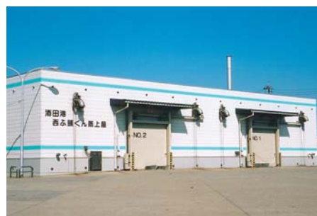
西ふ頭くん蒸施設
