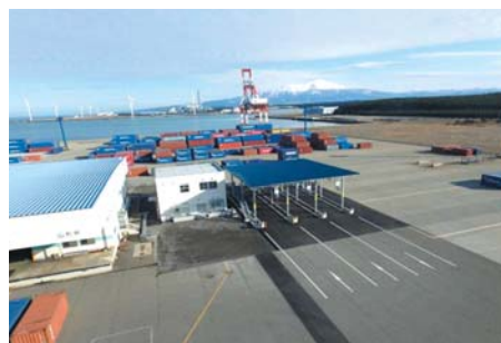
管理上屋(管理棟、トラックゲート)
