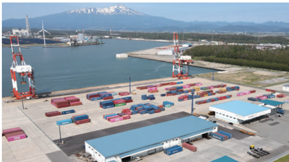
酒田港国際ターミナル全景 高砂西上屋、コンテナ・フレート・ステーション (CSF) 上屋、コンテナヤード
