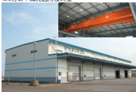
古湊ふ頭上屋（天井クレーン設置、吊上能力:20t*1）
